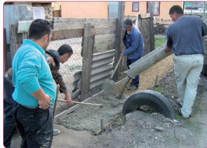
Közmunkások betonjárdát építenek a városban. A tervek szerint 1500-2000m járda fog megújulni munkájuk során.
